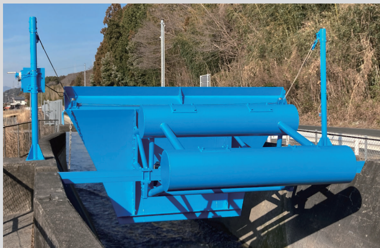
▲ 自動水位調整機。施工後。
