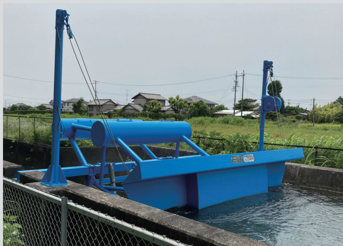
▲ 自動水位調整機。施工後。
