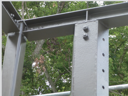
▲ 腐食の一因となる水分子*に覆われても、鋼材への水の到達をリックファイバーがブロック。
