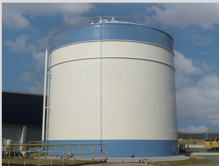
▲ 施工後。トップコートは水性を使用。
