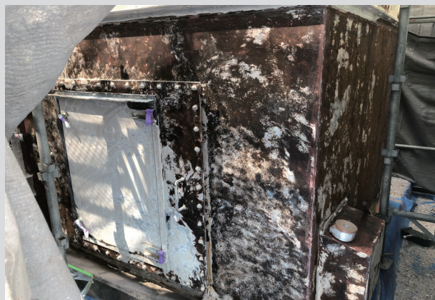
▲ 2・3種混合ケレンでの素地調整後。リックファイバーはこの状態で塗装可能。
