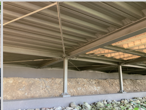
▲ デッキ上面からの雨水が流れる。下面の防錆対策も抜かりなく。
