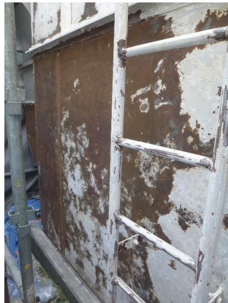
劣化した塗膜を除いた素地面
