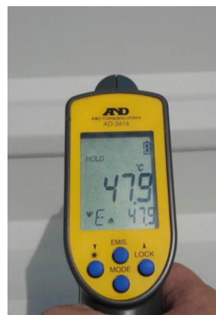
Liq-Fiber 施工後 折板温度 : 47.9℃
