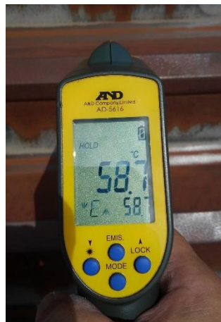
施工前 折板温度 : 58.7℃
